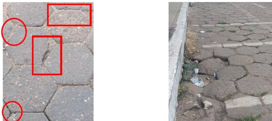
Figura 4. Defeitos de desgaste e afundamento.
