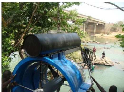
Figura 3. Instalação de uma turbina Monofloat
