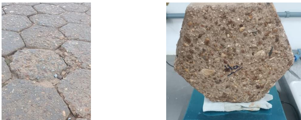
Figura 5. Defeito de desgaste.
